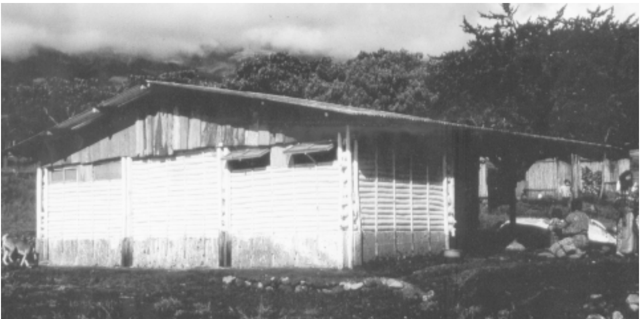
9-7 Prototipo de una vivienda antisísmica de bajo costo, Guatemala 1978
