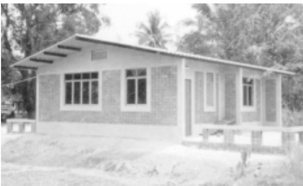
7-12 y 7-13 Vivienda piloto, Tailandia 1984 (Weinhuber 1995)
