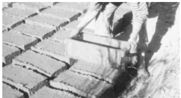
7-2 Proceso de elaboración de adobes en Ecuador
