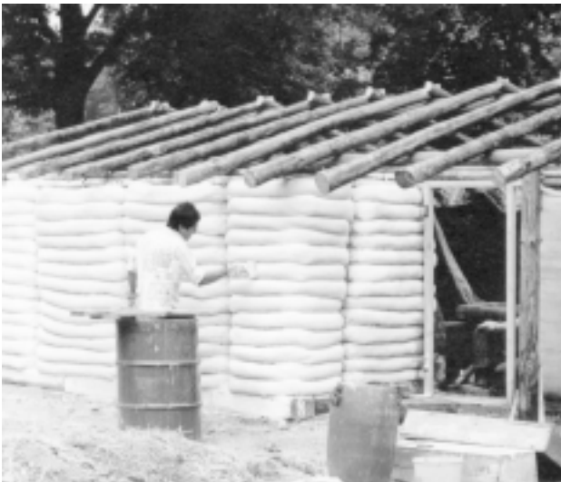
9-2 y 9-3 Muro de mangueras textiles rellenas
