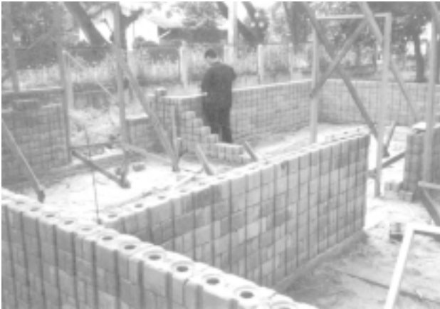
7-11 Bloques machihembrados (Weinhuber 1995)
