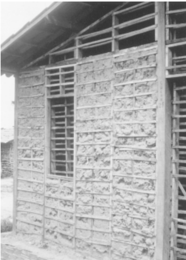
8-3 Bahareque con elementos prefabricados CEPED, Brasil
