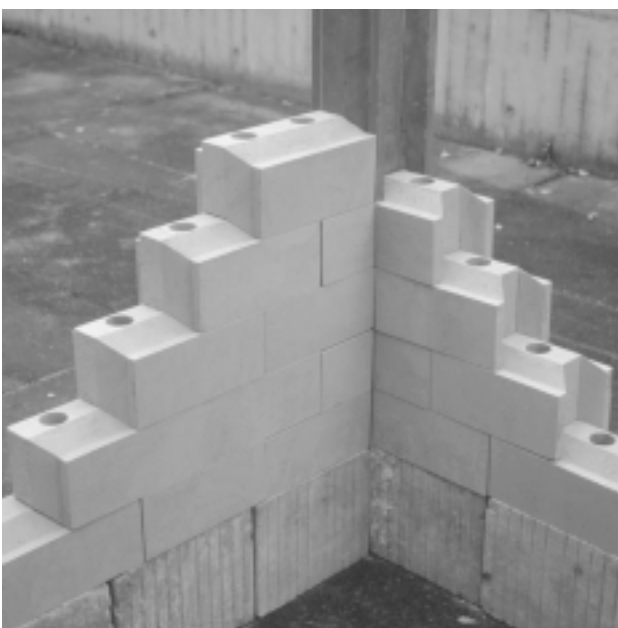
7-15 Sistema de bloques machihembrados FEB, 2001
